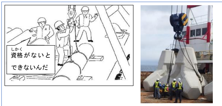
図-1 玉掛作業は資格のある作業員だけが行う
